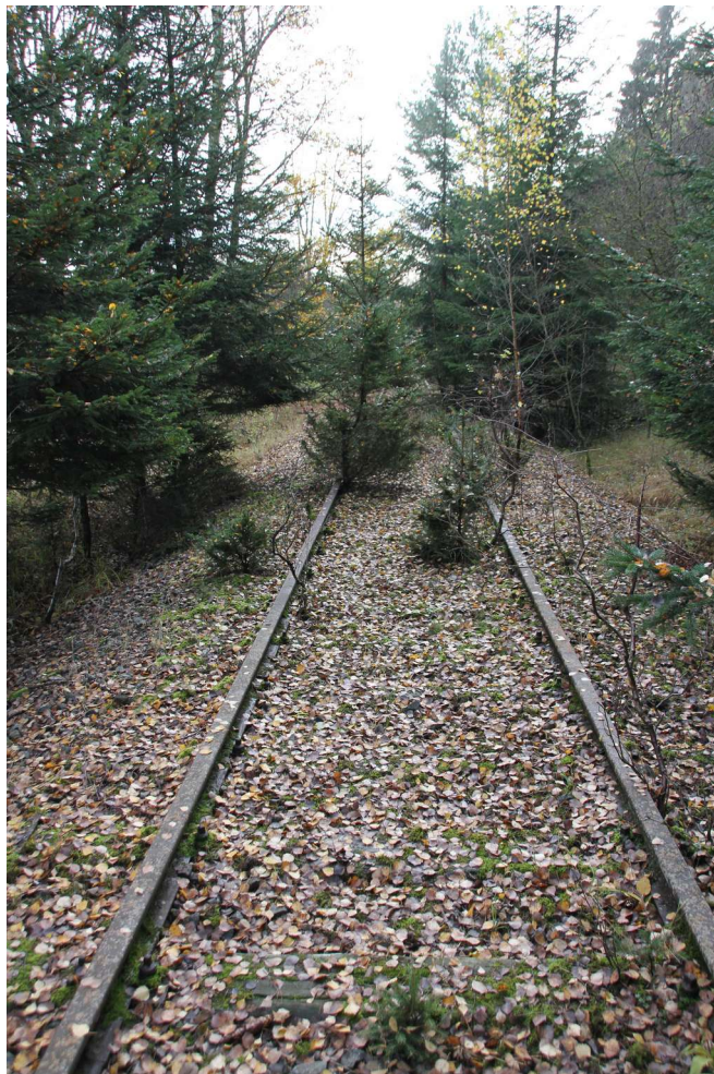
Abb. 4.2.1: Gleis der ehemaligen Bahnstrecke Steinholz-Hirschhagen
